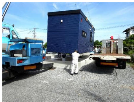
⑤ クレーンにて 設置します
