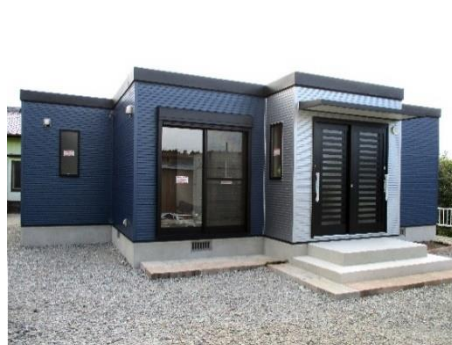
⑥ 棟上げは一日 で組上げ完了 繋ぎ合わせて 内装の仕上が 終われば完成 です
